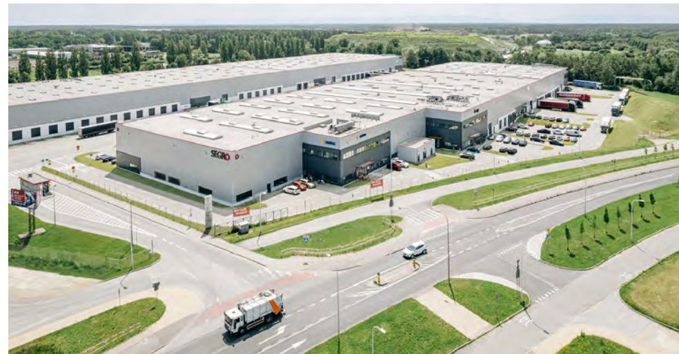
SEGRO Park Tychy, Przejazdowa, Poland
